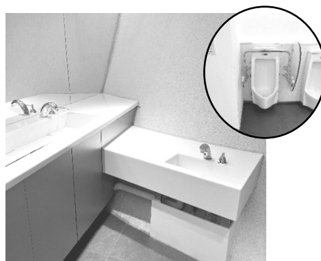
圖 10 無障礙小便器及高度較低洗臉盆
